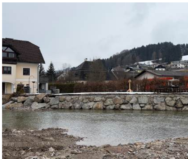
Arbeiten für den Hochwasserschutz in der Grestner Straße
