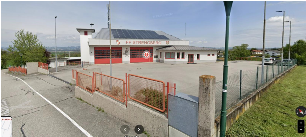
Abbildung 11: Feuerwehrdepot östlich der Buchstraße
