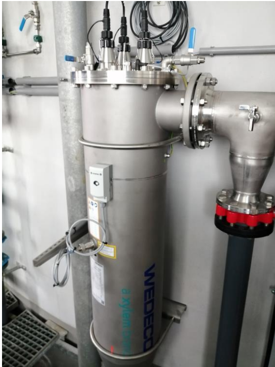
Abbildungen 4 und 5 UV-Anlage des Brunnenwassers "Au"
