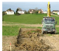
2015: Grundbau der Sportplatzstraße.
