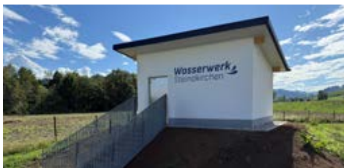
Der neue Brunnen in Götzwang ist fertig
