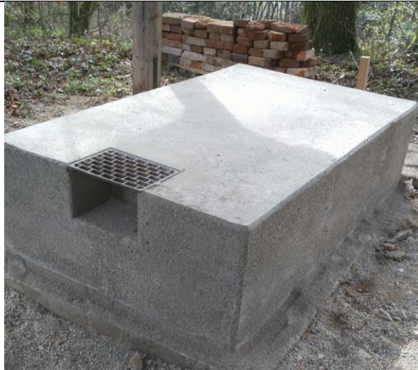
18. März 2024: Ausschalen und Kratzen des Sockels, Das Aschengitter ist schon fix einbetoniert.
