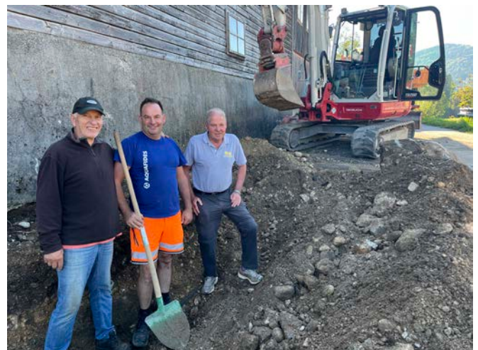
Herr Otto Bartl, unser Bauhofleiter Andreas Leichtfried und Herr Rudolf Jagersberger von der Firma Wurzer bei den Bauarbeiten.
