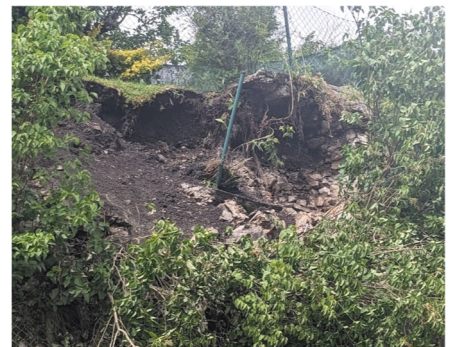
Der Abbruchbereich im Detail
