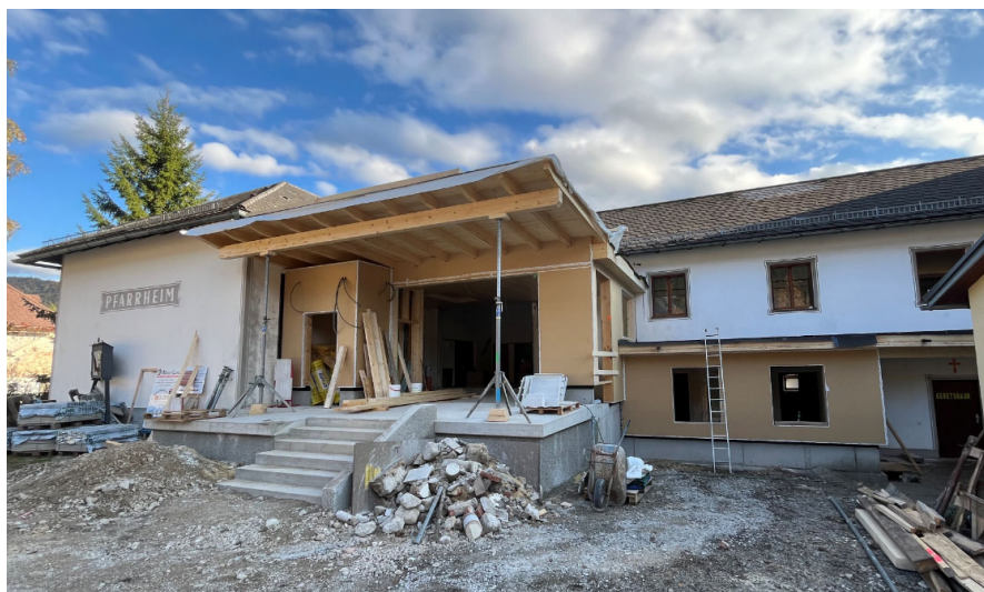
Der Eingangsbereich ins Pfarrheim wird komplett neu und auch barrierefrei gestaltet.
