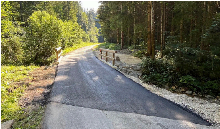
Asphaltierungsarbeiten Brücke Kampen 2
