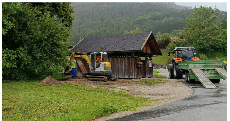
Recyclingplatzl Kleinhollenstein saniert
