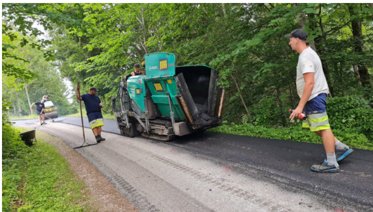
Sanierung Güterweg Seymannsberg
