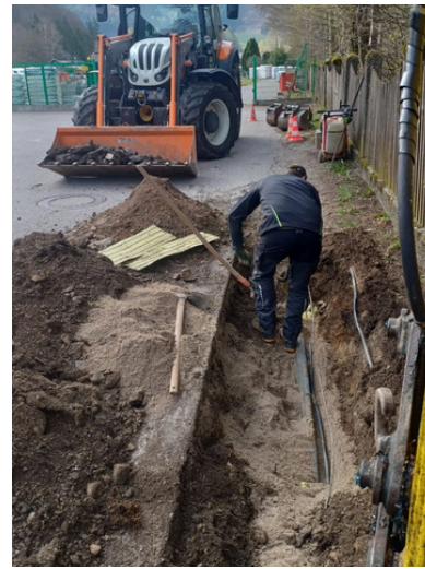
OGA Kabelschaden - TV Kabel
