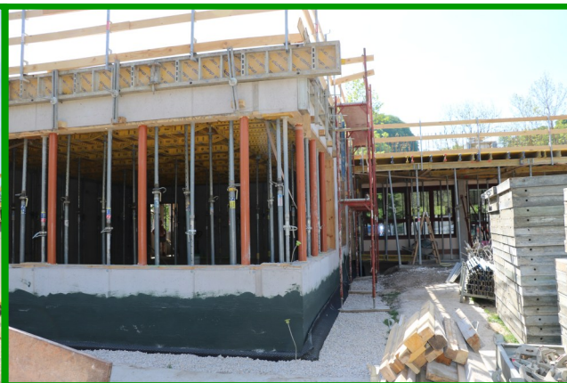
Stand Mai 2026: Der Zubau des Bewegungsraumes ist fertig, nun kann die Decke betoniert werden.
