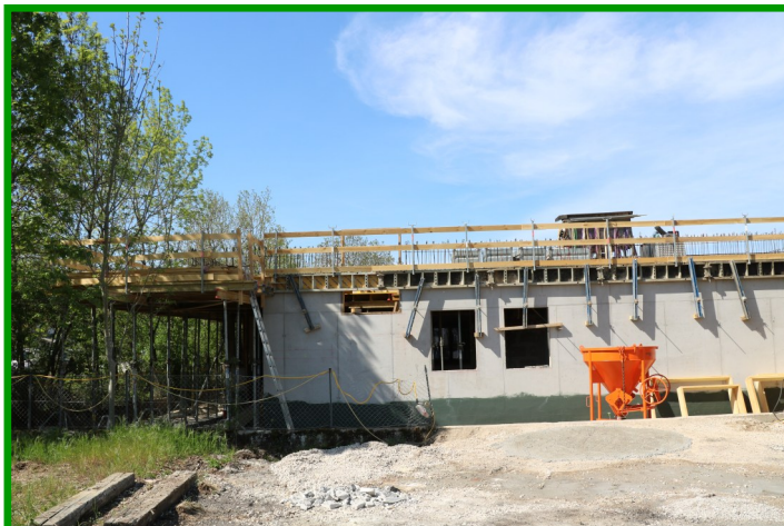
Stand Mai 2026: Der Zubau des Bewegungsraumes ist fertig, nun kann die Decke betoniert werden.
