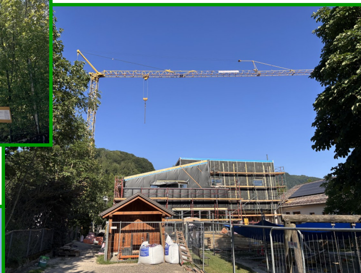
Stand Juni 2026: Fenster wurden eingebaut und Vorbereitungsarbeiten für die Isolierung und Fassade gemacht.
