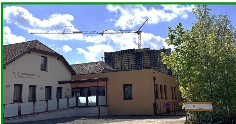
Stand Juni 2026: Die Außenwände des Musikheims werden betoniert und Abdichtungsarbeiten erledigt.
