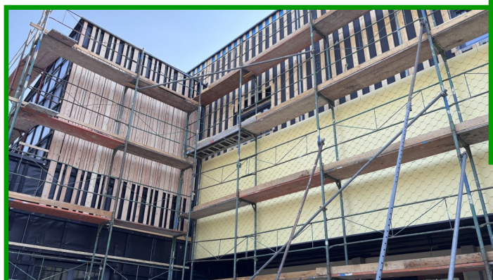
Stand Juli 2026: Fassadenverschalung mit Lärchenholz und Wabendeckung aus Faserzement, Innenausbau mit Aufstellung der Zwischenwände und Verlegung der Fußbodenheizung und Estrich
