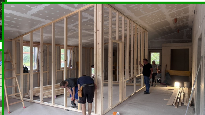
Stand Juli 2026: Fassadenverschalung mit Lärchenholz und Wabendeckung aus Faserzement, Innenausbau mit Aufstellung der Zwischenwände und Verlegung der Fußbodenheizung und Estrich
