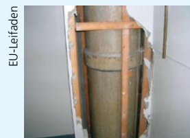
Abfluss- bzw. Abgasrohre aus Asbestzement
