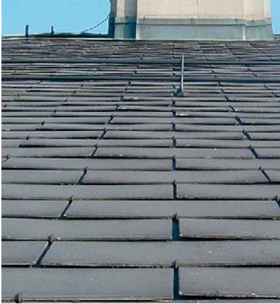
Asbestzementdach
