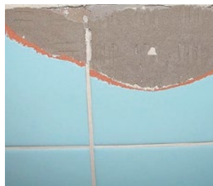
Asbesthaltige Fliesen, oft auch mit asbesthaltigem Kleber aufgebracht
