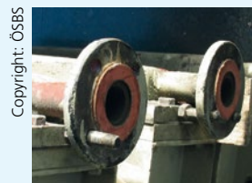
Asbesthaltige Dichtungen
