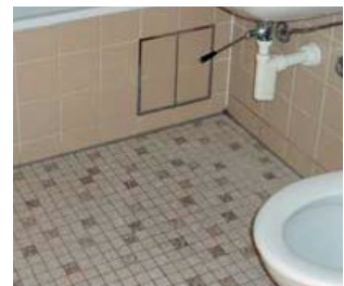
Asbesthaltige Fliesen, oft auch mit asbesthaltigem Kleber aufgebracht
