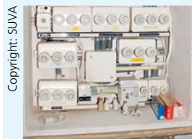
Brandschutzplatten in Elektroanlagen
