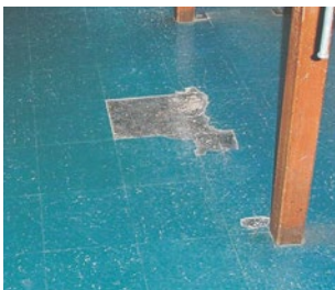
Asbesthaltiger PVC-Boden
