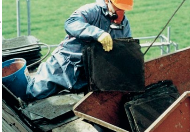
Platten werden auf dem Dach in die Entsorgungsmulde gelegt
