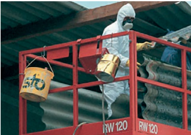
Demontage von Welleternitplatten mittels Hubsteiger
