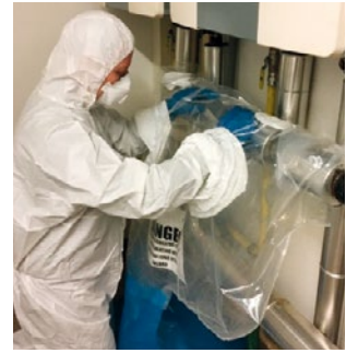
Aufbau eines Glove-Bags
