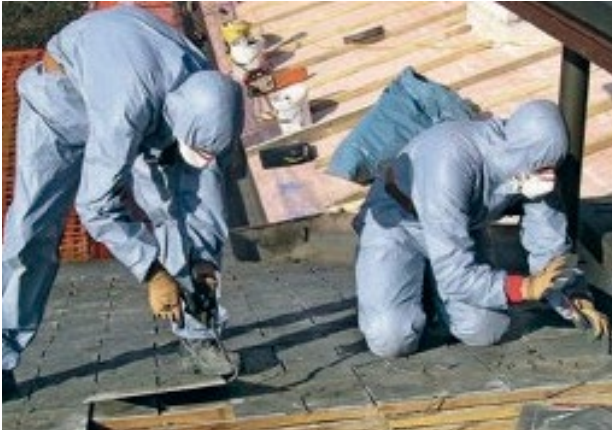
Aushebeln einzelner Platten unter Verwendung der notwendigen persönlichen Schutzausrüstung
