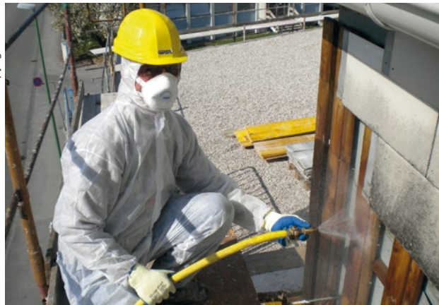
Befeuchten der Fassadenplatten vor und während der Demontage
