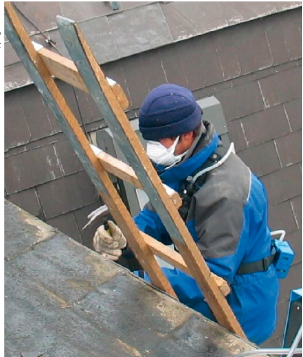
Personenbezogene Probenahme bei Dachdemontage mittels Luftpumpe und goldbedampftem Mikrofilter
