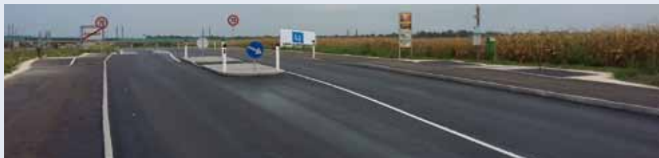
Bild: Der neue Geh- und Radweg samt Querungshilfe.
