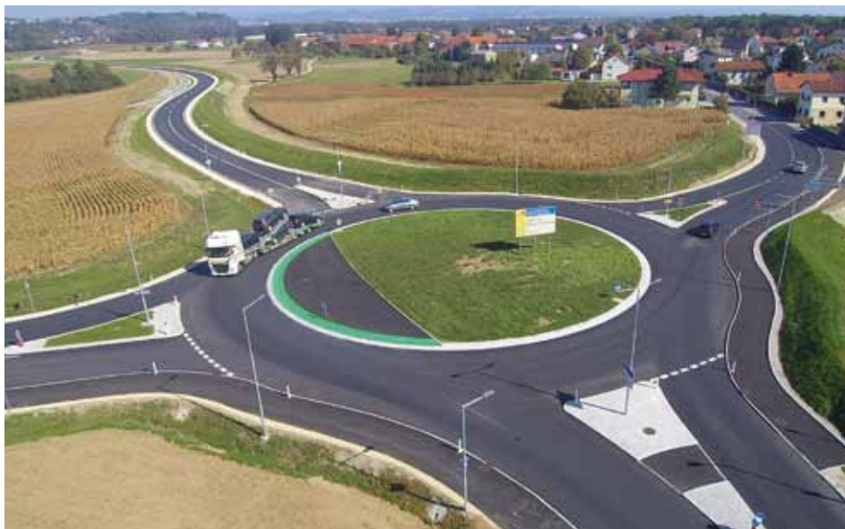
Der Kreisverkehr vor Windpassing ist der neue Verkehrsknotenpunkt
