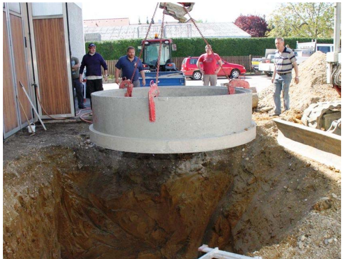
FF Euratsfeld – Einbau Brauchwasseranlage (Foto Winkler)
