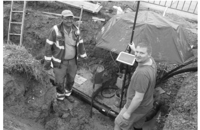
Foto: Unmittelbar bei der Verlegung werden die neuen Lichtwellenleiter-Leerrohre schon eingemessen. gfGR Roland Forster ist einer der Spezialisten, die in der Kleinregion Donau-Ybbsfeld auf diese Tätigkeit eingeschult sind.
