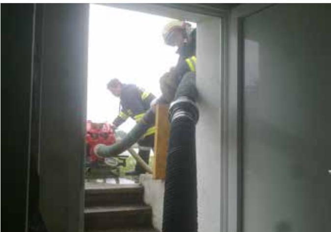
*Aussumpen eines Kellers mittels Tragkraftspritze*
