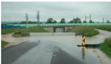
Die Dambalkensperre im Bereich der Eisenbahnunterführung trägt wesentlich dazu bei, dass das Hochwasser nicht das Trinkwasser verunreinigt.
