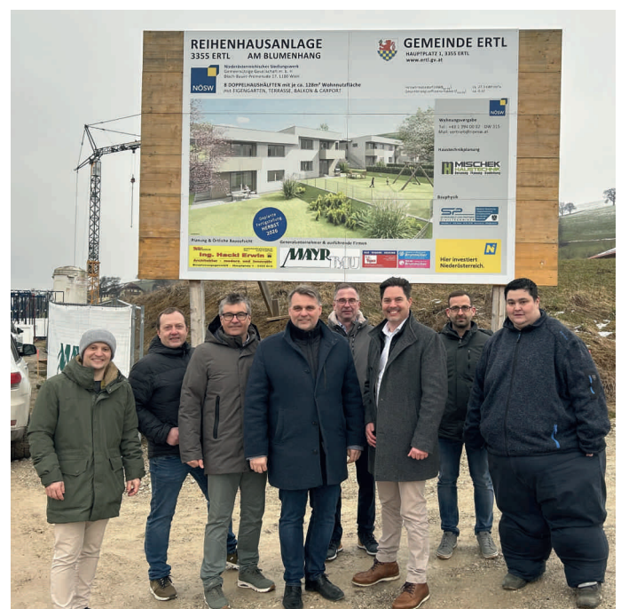
vlnr: Peter Edermayr (ÖBA), Christian Matzenberger (Vize-Bgm.), Josef Forster (Bgm.), Lukas Michlmayer (LAbg.), Franz Forster (Prok. Mayr Bau), Hannes Kaiser (GF NÖSW), Christian Schallauer (Bauleiter), Thomas Kerschbaumer (GF Hackl)
