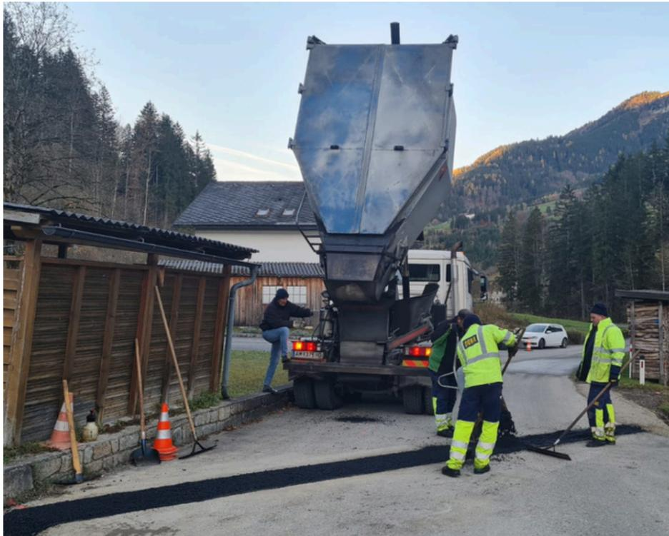
Am Güterweg Schelchen waren Grabungsarbeiten für die Neuverlegung von Kabeln notwendig. Diese wurden im Zuge der allgemeinen Ausbesserungsarbeiten mitasphaltiert.
