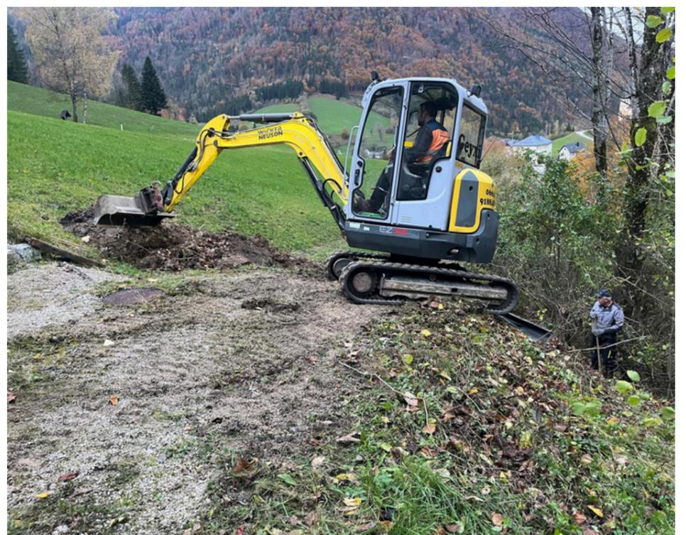
Verstopfung durch einwachsende Baumwurzeln beim Überlauf des Gegenbehälters wurde entfernt.
