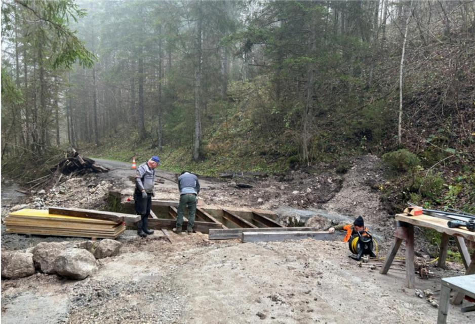
Im Herbst wurde die Brücke Kampen 2 zwischen Legoner und Kampen abgebrochen und neu errichtet. Sie wurde zwischenzeitlich geschottert und wird im Frühjahr 2026 asphaltiert.
