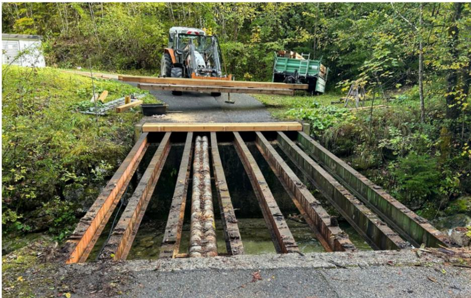
Die Tragschicht der Brücke zum Kraftwerk Schreybach und das Gelände wurden erneuert.
