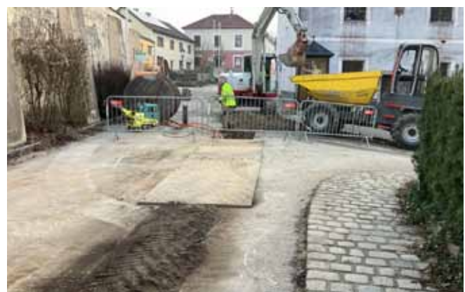
Foto: Glasfaser-Baustelle in Ardagger Stift.
