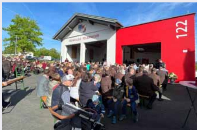
Foto: Viele Gäste waren gekommen um das neue Gebäude der FF Stefanshart zu besichtigen. © zVg
