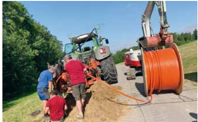
Foto: Verlegung der Glasfaser-Leerrohre.
