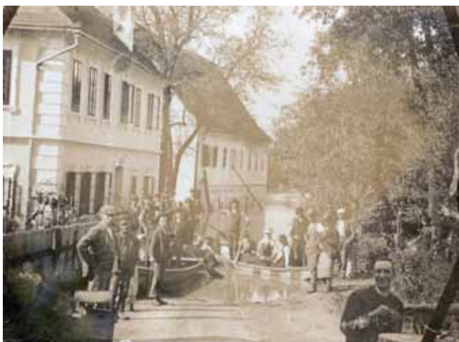
Foto: Hochwasser am 16.9.1899
