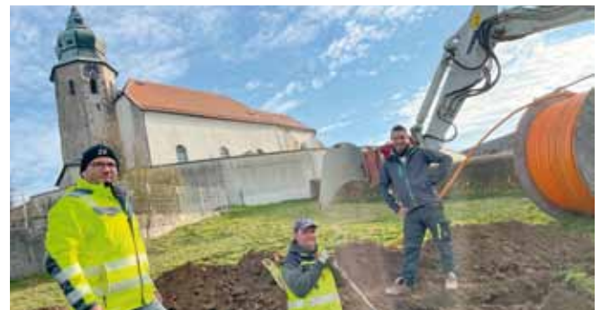
Foto: Verlegearbeiten der Fa. Hinterholzer in Kollmitzberg.
