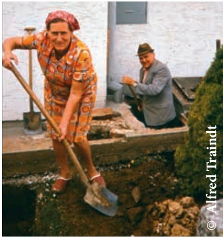
Familie Glinz bei den Vorbereitungen für den Hausanschluss 1978
