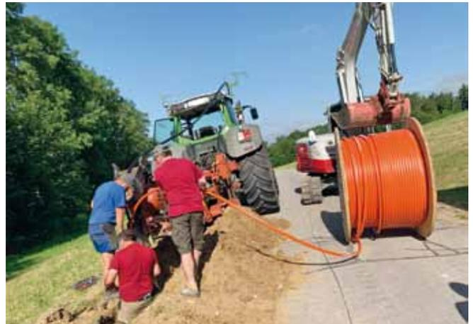
Foto: Verlegung der Glasfaser-Leerrohre.
