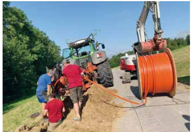
Foto: Verlegung der Glasfaser-Leerrohre.
