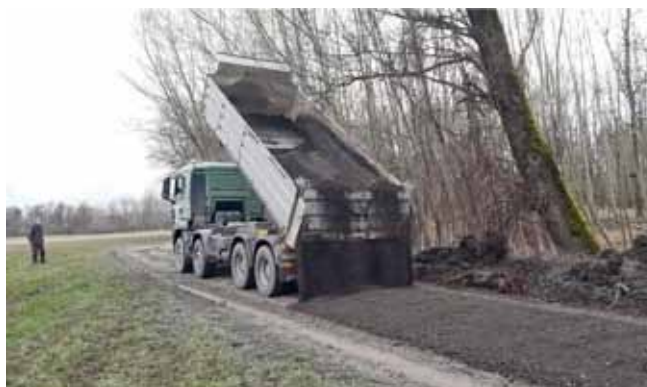
Foto: Dauerhaft stabile Wege wurden in der Au geschaffen.
