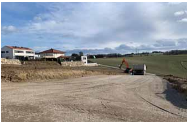
Foto: Baustellen Sonnenhang Stephanshart.
