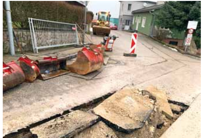
Foto: Baustelle LWL und Wasserleitung in Ardagger Stift, Pfaffenberg, wo bereits fleißig gearbeitet und ein Hausanschluss um den anderen hergestellt wird. © zVg
