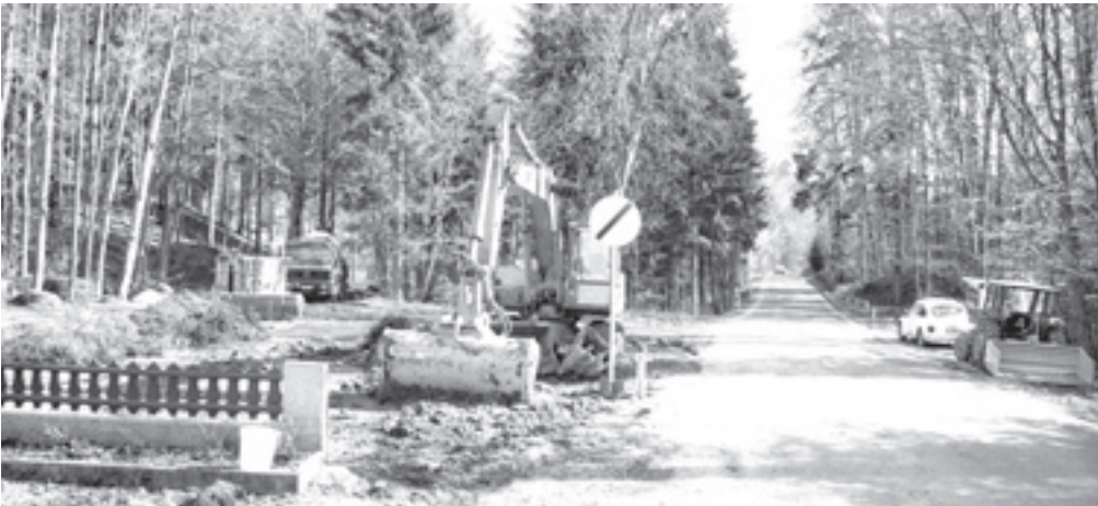
Am 28. März 1996 wurde die Sohle der Drucksteigerungsanlage in Hinterberg betoniert.
