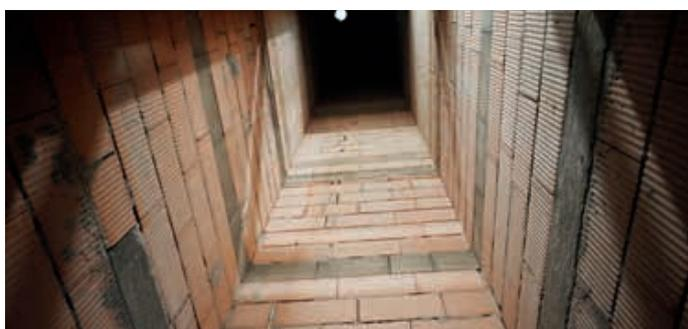
Für den Bau eines Liftschachts musste im Kellergeschoß ein eigenes Fundament gegossen und einige Räume in den einzelnen Stockwerken neu umstrukturiert werden.
