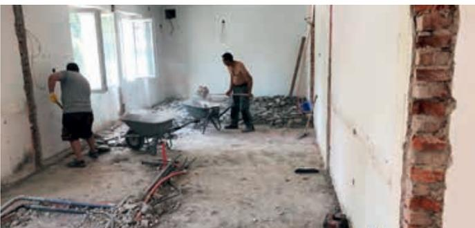
Für die Verlegung neuer Leitungen und Rohre musste der alte Estrich im ersten Stock entfernt werden.
