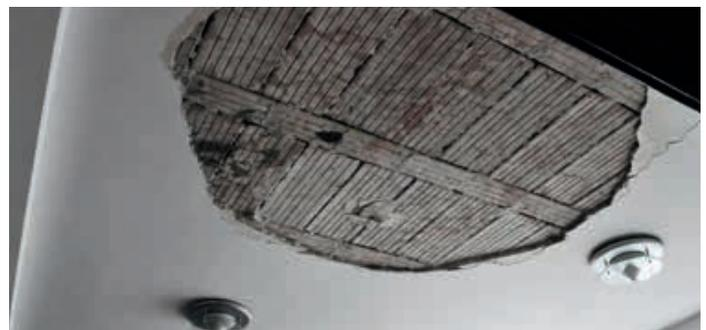
Bei den Stemmarbeiten kam es zu einer unvorhergesehenen Planänderung: durch die entstandenen Vibrationen löste sich im darunterliegenden Stockwerk der Deckenputz.
