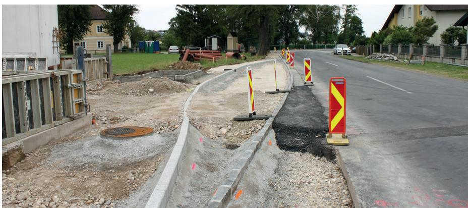
dem gleich die Leerverrohrung für das Glasfaserinternet mitverlegt. Nach der Fertigstellung wird die Landesstraße von Triesenegg bis nach Allersdorf noch mit einer neuen
