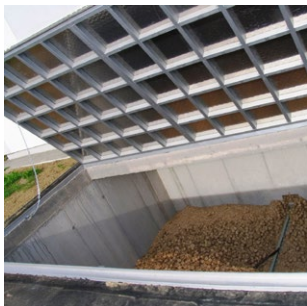
Miscanthusheizung Kindergarten Hofamt Priel
