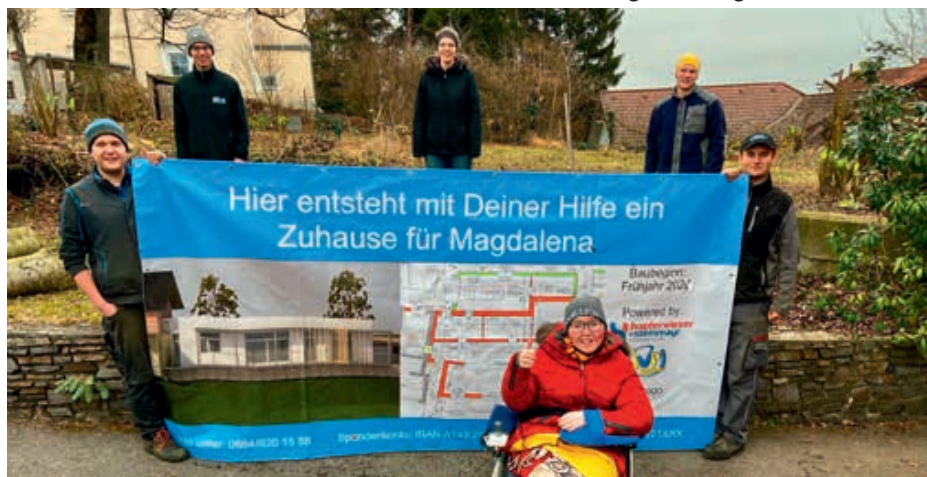
Magdis Freunde von der JVP Krahof haben bereits im Dezember geholfen, das Grundstück für die Bauarbeiten vorzubereiten.
