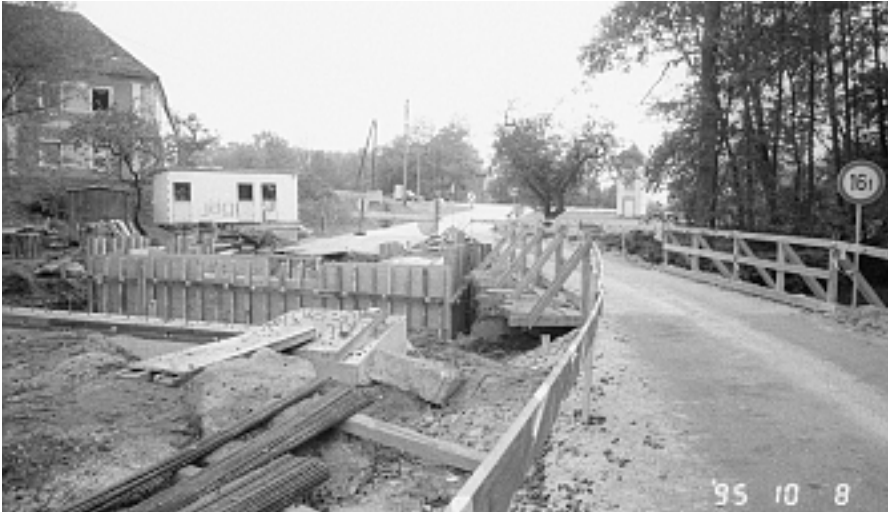
Neubau der Brücke zwischen Feldmühle und der Pichl-Kreuzung im Herbst 1995.
