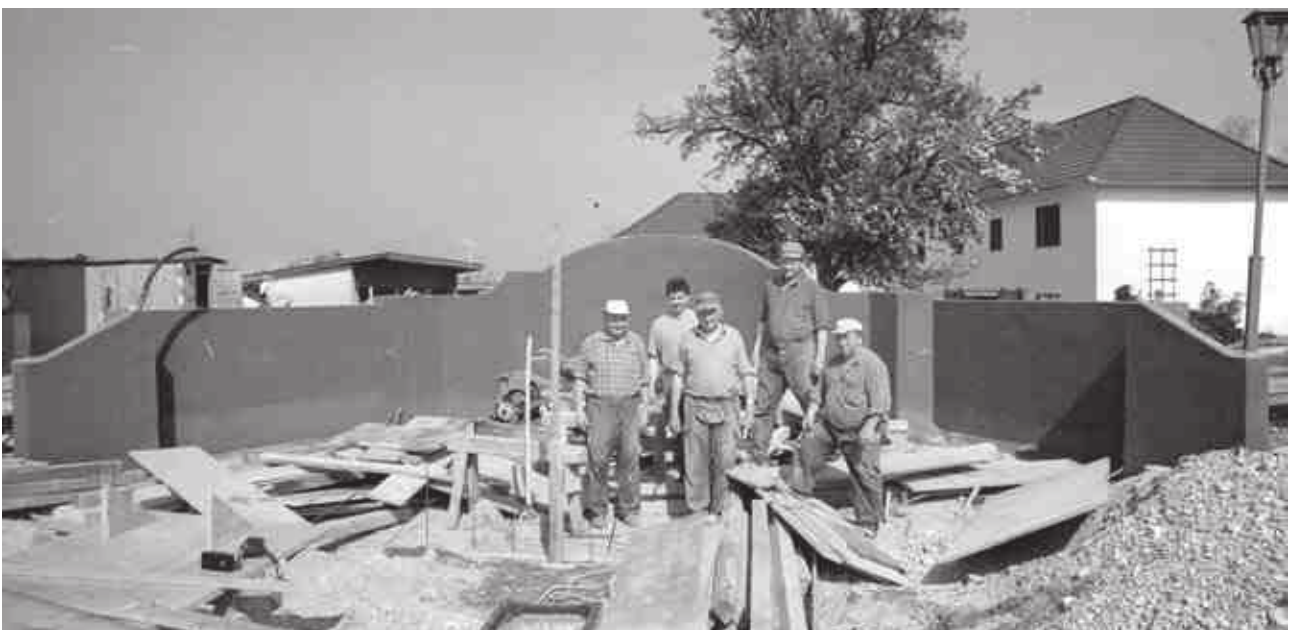
Blick auf den Mock-Platz mit den Arbeitern der Firma Ing. W. Jungwirth GmbH am 21. April 1994
