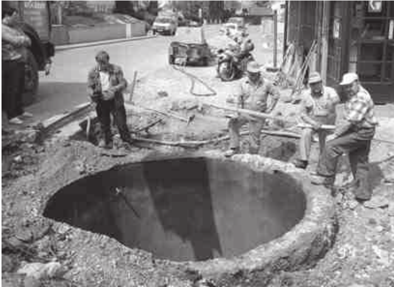
Arbeiten am Tiefbrunnen zwischen Ortsdurchfahrt und Mock-Platz.
