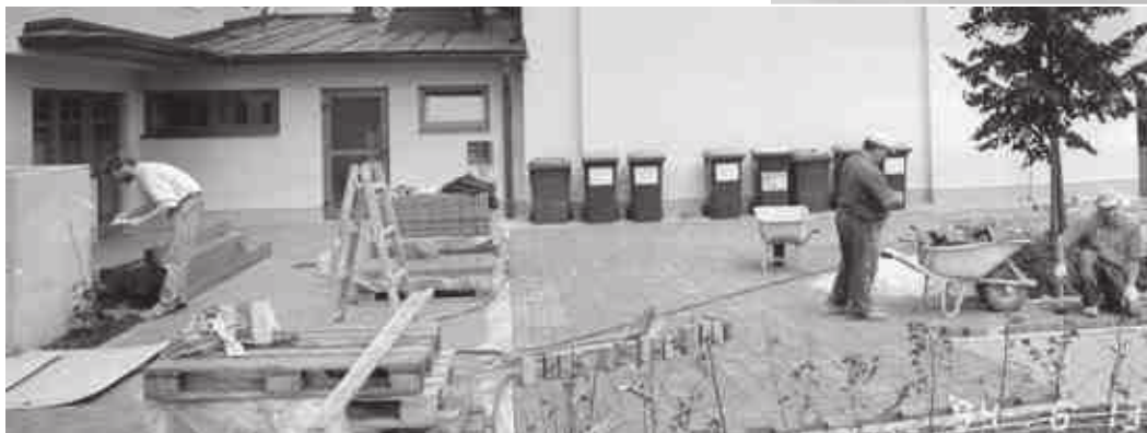
Arbeiten an den Außenanlagen bei der VS am 13. Juni 1994
