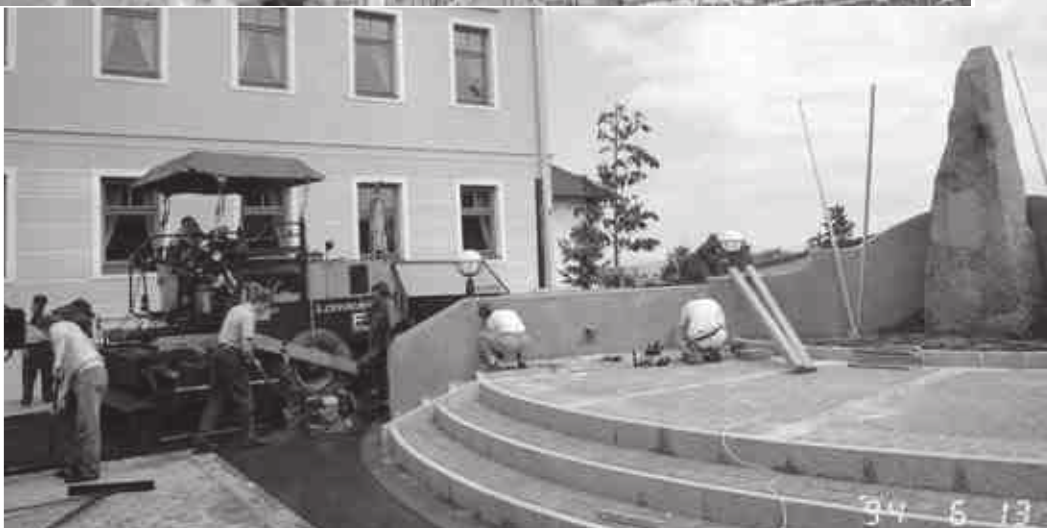
Asphaltierung des Mock-Platzes am 13. Juni 1994
