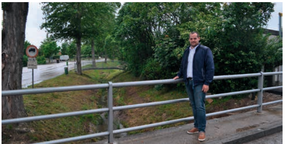
Bürgermeister Christoph Haselsteiner freut sich, eine weitere Maßnahme zur Hochwassersicherheit präsentieren zu können.
