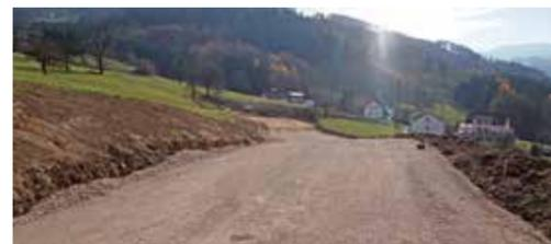
Für den Bereich Sonnenhang (Kinzl Gründe) wurde die Errichtung einer Rohtrasse für die Aufschließungsstraße an die Firma Schneckenreither vergeben. Kostenpunkt EUR 55.943,40 netto. Diese ist bereits kurz vor der Fertigstellung.
