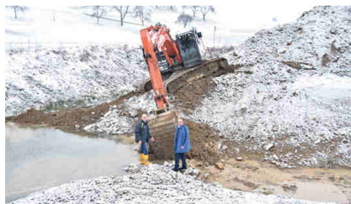
Die letzten Arbeiten vor dem Durchbruch
