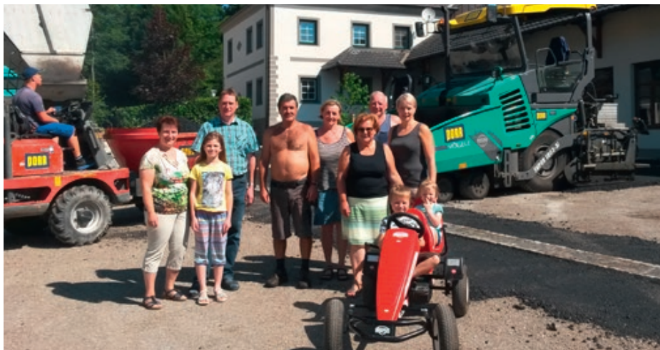
In Perasdorf wurden Asphaltierungsarbeiten durchgeführt, nachdem die Leitungen für das Hochwasserschutzprojekt verlegt wurden.
