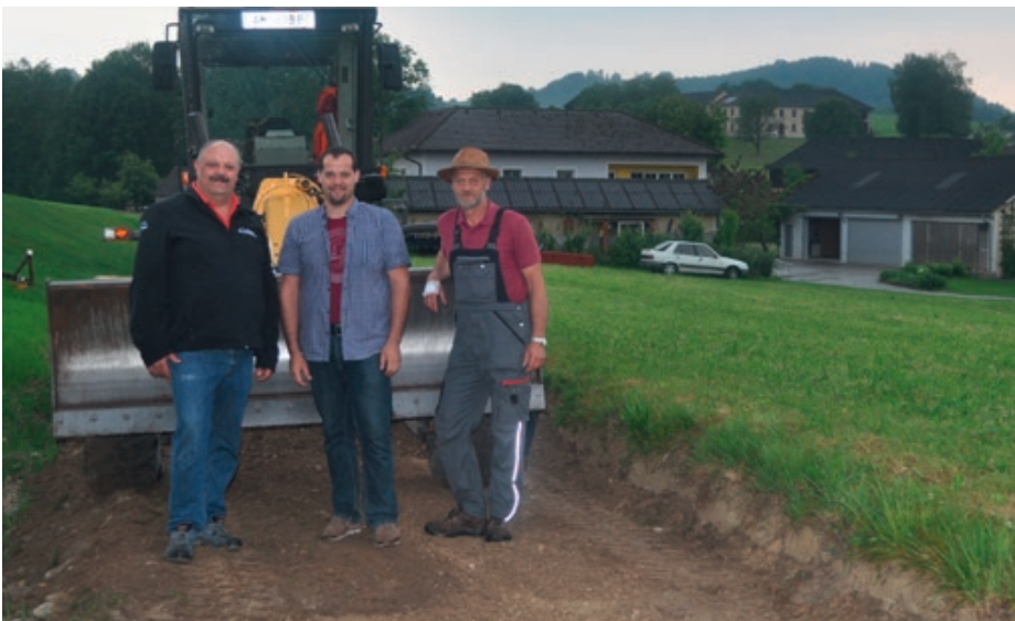
Im Gemeindegebiet wurden wieder einige Güterwege saniert. Auch in Thalling stand eine Maßnahme an der Reihe.
