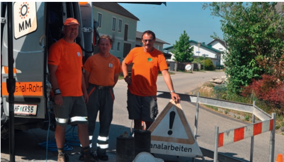
In Leutzmannsdorf wurden zahlreiche Kanalschächte saniert, nachdem bei der routinemäßigen Überprüfung leichte Mängel festgestellt wurden.
