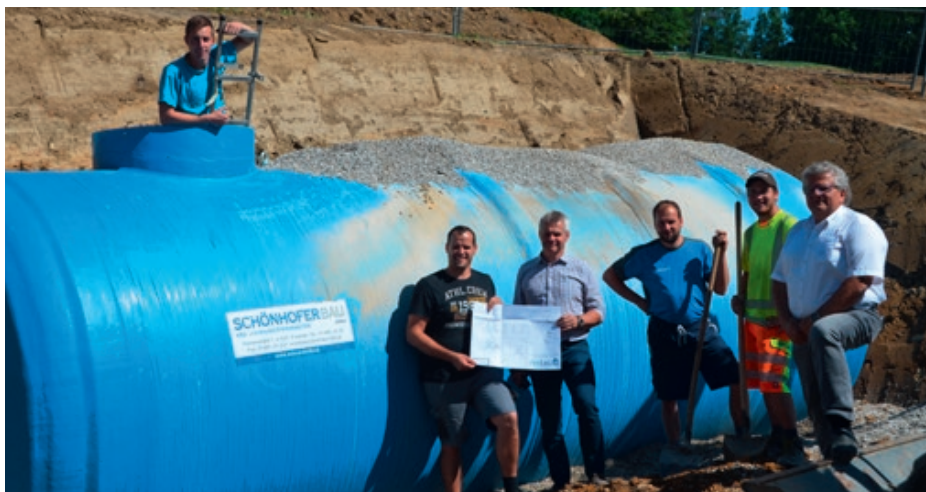
Zur Sicherung der Wasserversorgung der Genossenschaft Krahof wurde ein 30 Kubikmeter - Wasserspeicher neben dem alten FF-Haus eingebaut.
