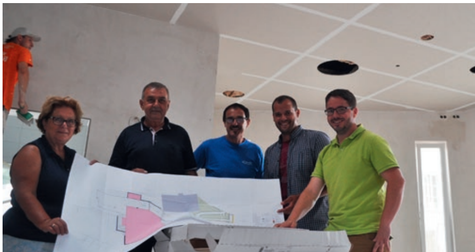
Die Errichtung des Georgsaales schreitet zügig voran. Im Moment wird die Decke gespachtelt und Fliesen verlegt.
