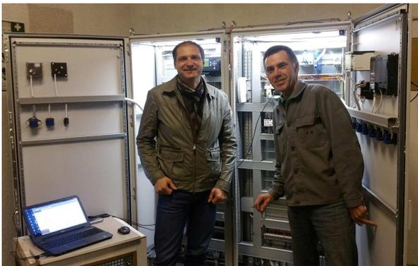
Seit Mitte Oktober wird von Hrn. Robert Hörhann die fast 40 Jahre alte Regelung und Steuerung des Kraftwerkes Schreybach erneuert. Die Hydraulikanlage wurde ebenfalls dem Stand der Technik angepasst. Damit verbunden ist auch eine Effizienzsteigerung und die Möglichkeit der Fernsteuerung der Anlage.
