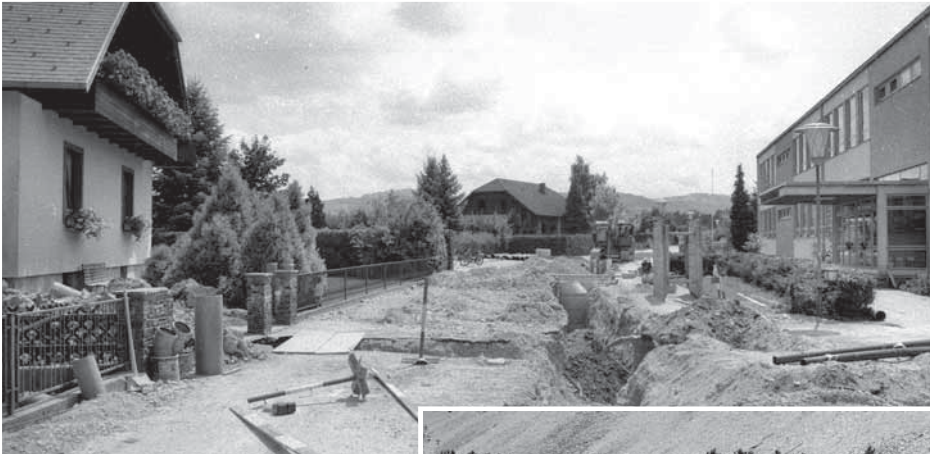
Links: Kanalbau in der Gemeinde- straße Hoher Rain Mitte Juli 1992
