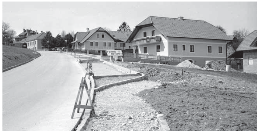
Errichtung eines Gehsteiges entlang der Gafringstraße (Bäckerberg) bis zur Guglumpfsiedlung. Foto vom 21. April 1992
