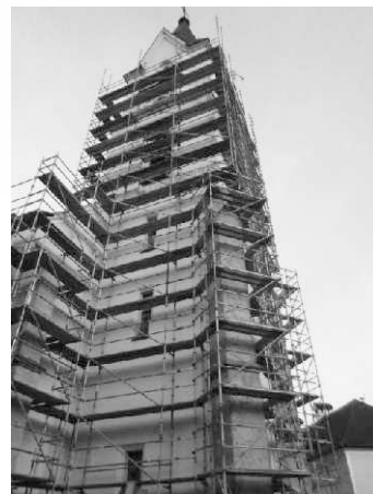
Foto: Markus Eder Blick auf den eingerüsteten Kirchturm
