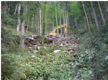
Mittlerweile wurde mit den Bauarbeiten bei der neuen Wasserversorgungsanlage begonnen. Die Quelle wurde freigelegt und die Quelfassung wird errichtet.
