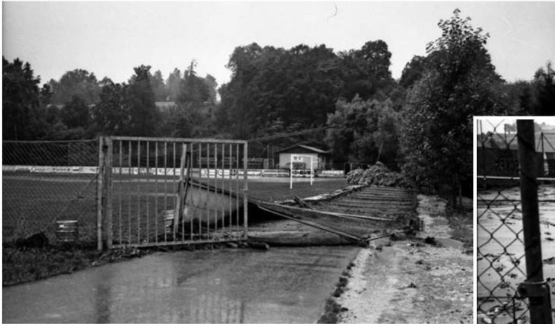
Bild links: Die Umzäunung beim neuen Fußballplatz wurde - ebenso wie bei der alten Sportanlage - von den Wassermassen niedergewälzt.
