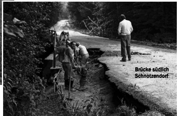
Die erst im Vorjahr asphaltierte Straße zwischen Niederaigen und Grub wurde komplett verwüstet. Meterlange Asphaltbahnen in voller Straßenbreite wurden abgetragen und auf die angrenzenden Wiesen geschwemmt.
