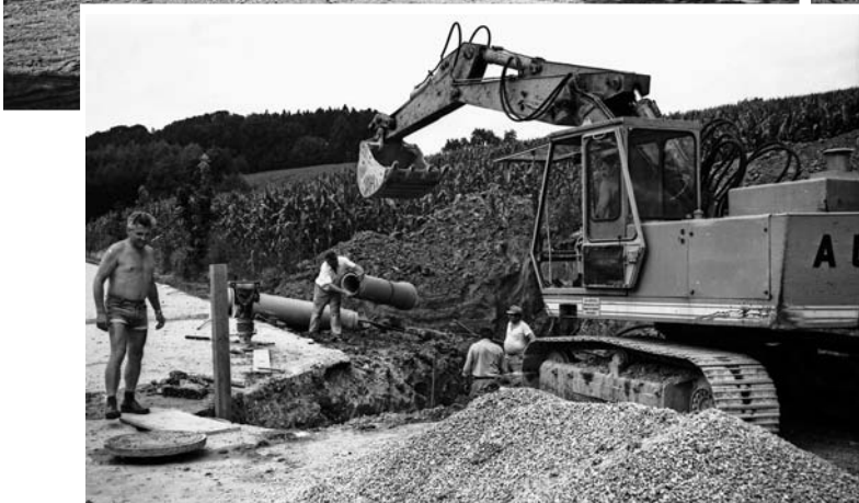
Verbreiterung der Straße sowie Verlegung der Ortswasserleitung und des Oberflächenwasser- kanales entlang der Neubauten Gruber, Leonhartsberger und Holzinger, Am Sportplatz
