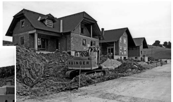
Verbreiterung der Straße sowie Verlegung der Ortswasserleitung und des Oberflächenwasser- kanales entlang der Neubauten Gruber, Leonhartsberger und Holzinger, Am Sportplatz
