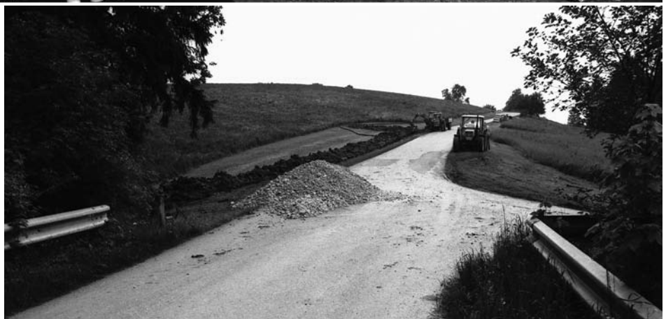
18. Mai 1989: Verlegung eines Drainage- schlauches entlang des Güterweges Windischendorf
