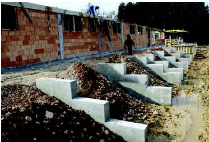
Fertigung der Fundamente für die Tribüne
