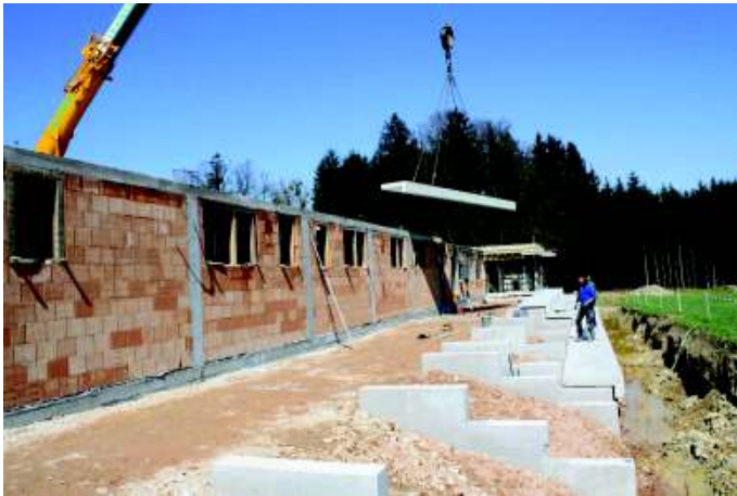
Verlegen der Fertigteile für die Tribüne
