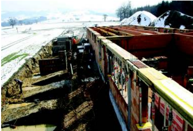
Fertigung der Fundamente für die Tribüne
