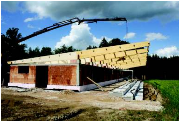
Versetzen der Leimbinder für die Dachkonstruktion
