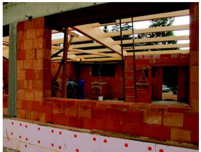
Aufmauern der Zwischenwände
