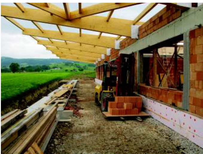
Versetzen der Leimbinder für die Dachkonstruktion
