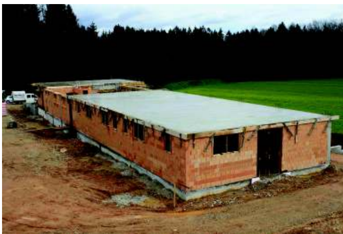
Betonieren der Massivdecke über den Nassräumen
