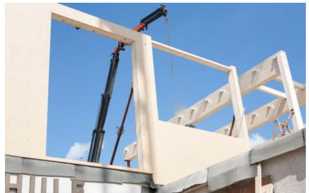
Die Dachkonstruktion über der Garderobe wurde entfernt und für den Aufbau der neuen Klassenzimmer vorbereitet
