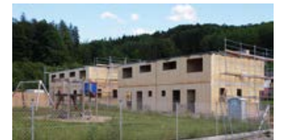
Bau von drei Doppelhäusern durch die Wohnbaugenossenschaft GEDESAG in der Rosenauer Sonnensiedlung
