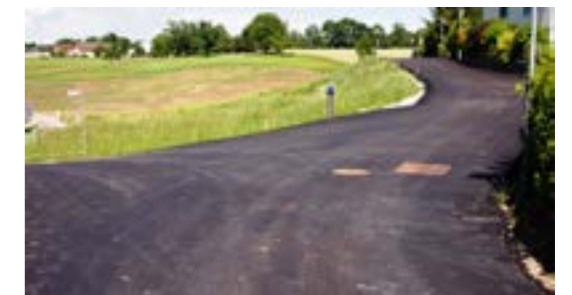
Endarbeiten beim Kanalprojekt in Windberg
