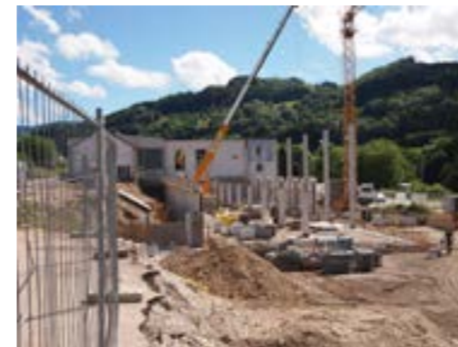
Hallenbau Fa. Böhler Profil in Bruckbach
