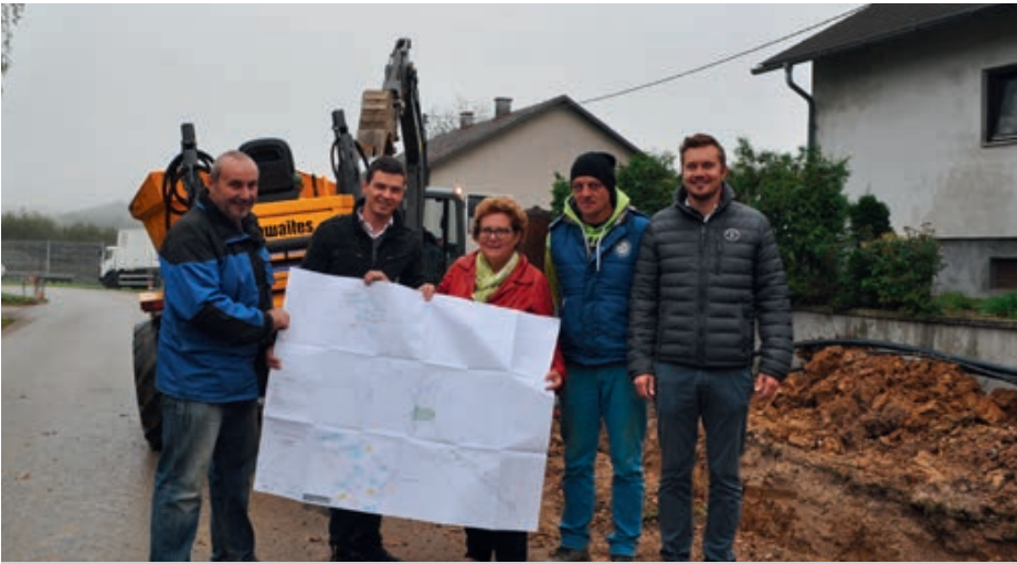
Die Häuser der Siedlung „Krahof Süd-West“ werden an des Wasserleitungsnetz angebunden. Die Arbeiten dafür sind bereits voll im Gange.
