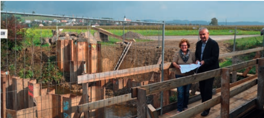
Bgm. Liselotte Kashofer und Amtsleiter Alfred Traindt besichtigen den Baufortschritt bei der Brücke über den Seiseneggerbach.
